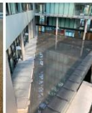
Techbrecken / Wasserveranlage (außen/innen)
